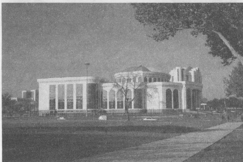
3.38-rasm. Toshkentdagi O'zbekiston ma'naviyat saroyi va Davlat kutubxonasi hududining landshafti.
